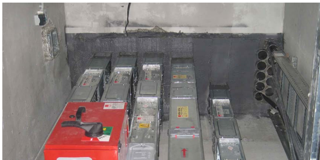
Универсальные огнезащитные кабельные проходки СПО-Э для шинопроводов и кабелей
